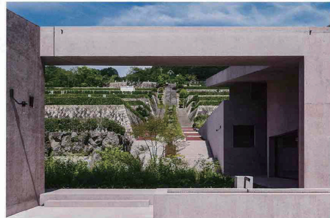
正面側のエントランス。既存の霊園の軸線の流れを流れてきた山の水は、「山野草の庭」の前後に配置された水盤にいったん貯まる
