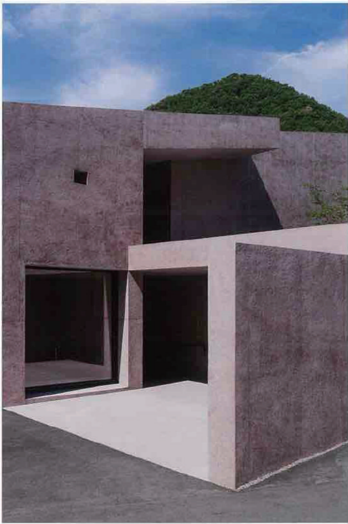
東面の駐車場側エントランス
