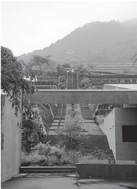
猪名川霊園礼拝堂・休憩棟 「この階段のラインこそが、建築の配置を決定づける軸線」とデイヴィッドがコメントしている。ひな壇上に構成された霊園の中央を1本の階段が頂上の納骨堂へとつなぐ。階段の真ん中には山からの水が流れ、水盤にたまり、そこから地下を通り小川へと向かう。水系も新しくデザインされた
