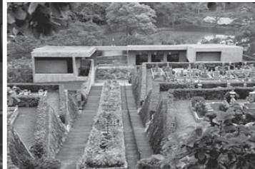
全景。左手前から礼拝堂、事務棟、エントランスを挟んでメモリアルルーム、ビジターラウンジ。壁、床、屋根は赤土色のカラーコンクリートを採用し、床は磨き仕上げ、壁と屋根はサンドブラスト仕上げ。周囲の景色や既存の石段に馴染む赤色の岩がそこに隆起してきたような印象を受ける
