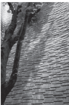
2万1千枚の屋根材は、同じ埼玉県内にある「鑄物のまち」川口で一枚一枚鑄造された。大澤さんは中村氏とともに工場に通い、厚さ4mmという薄さを実現するため、研究開発に一年半を費やした。エイジングし、苔や虫の這う跡が豊かな変化をもたらしている
